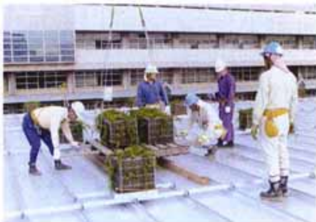
右：昨年完成した新東京郵便局の屋上にドット式に設置された緑化ユニット。荷重制限や熱対策をクリアするための実験的試みとして注目される。 左：ナーセリーで養生したものを現場では設置するのみ。作業は短期間で終了する。
